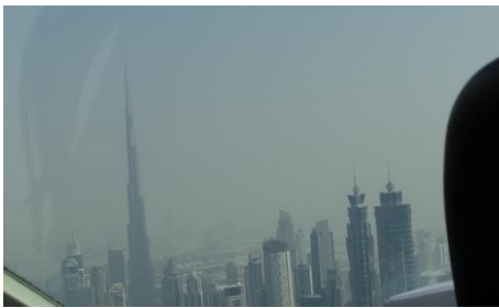
Burj Khalifa culmine à 828 m, entourée des gratte-ciel de 300 m
